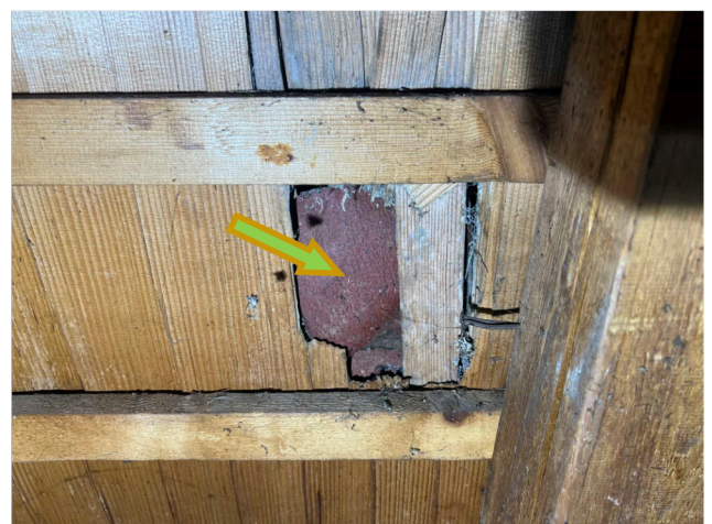
DG, Dachboden (Detail Dach) Holzlattung und -täfer: kein Asbestverdacht dahinter DP1: Dachpappe rot bituminös, kein Asbest, kein PAK-Hinweis dahinter Ziegel: kein Asbestverdacht
