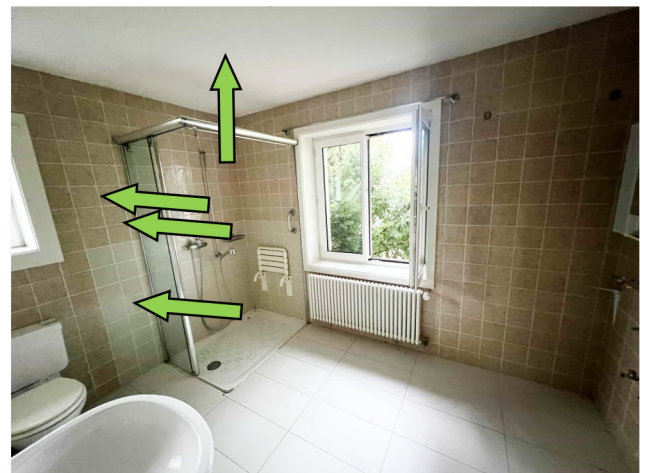
OG, Dusche PK3-1: Fliesenkleber Wand braun gemustert, kein Asbest PK3-2: Fliesenkleber Wand beige uni, kein Asbest VP9: Wand Grundputz Dusche, kein Asbest VP10: Deckenverputz Dusche, kein Asbest Bodenfliesen weisslich gross (nach 1990): kein Asbestverdacht
