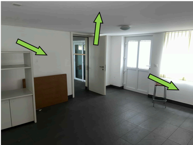
UG, Hobby VP4: Wandverputz AW Hobby, kein Asbest VP5: Wandverputz IW Hobby, kein Asbest Deckenverputz auf Gipsplatten baugleich VP12: kein Asbest Plattenbelag, Fenster (nach 1990): kein Asbestverdacht
