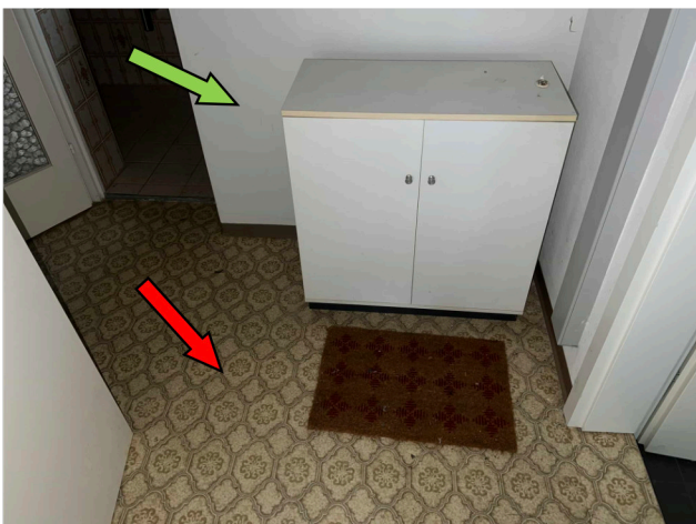
UG, Gang BB1: Bodenbelag beige Fliesenoptik CV, asbesthaltig VP2: Wandverputz Gang, kein Asbest
