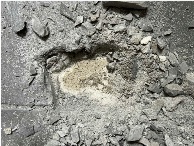
UG, Hobby (Detail Boden) Plattenbelag (nach 1990), darunter Beton: kein Asbestverdacht
