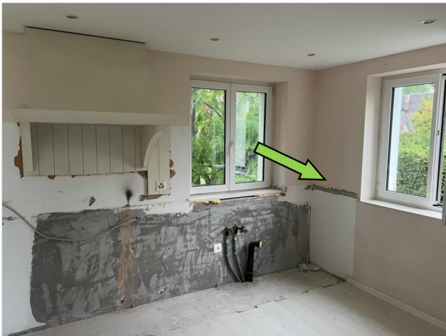
EG, Küche VP8: Wandverputz Küche, kein Asbest abgehängte Gipsdecke, Fenster (nach 1990), Laminat, darunter Unterlagsboden: kein Asbestverdacht
