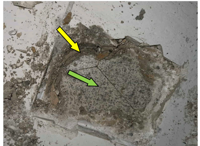
OG, Dusche (Detail Boden) Bodenfliesen weisslich gross (nach 1990): kein Asbestverdacht darunter PK4: Fliesenkleber Boden w/g, asbesthaltig darunter PK5: Fliesenkleber Boden gesprenkelt, kein Asbest darunter Betonboden: kein Asbestverdacht
