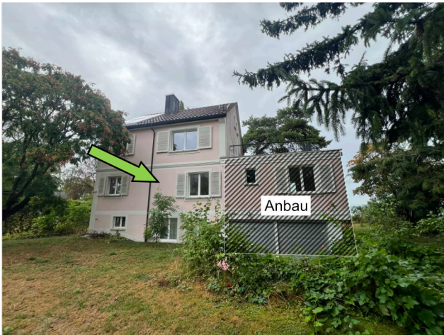
Seeweg 4, Südwestfassade Aussenverputz rosa grob baugleich VP1, kein Asbest Anbau (zw. 2008-2011): kein Schadstoffverdacht
