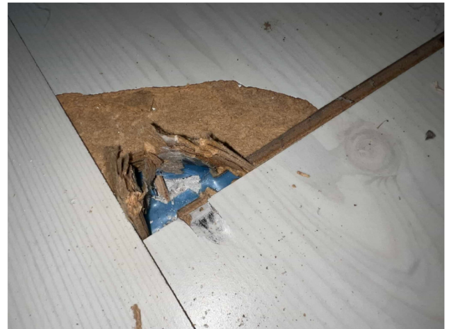
EG, Wohnen (Detail Boden) Laminat, darunter Kunststoffolie, Unterlagsboden: kein Asbestverdacht
