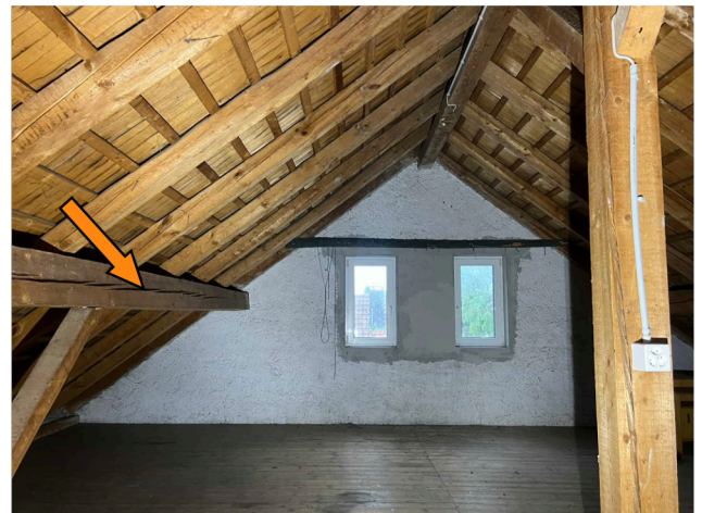
DG, Dachboden Wand mit Kalkputz, Fenster mit weichen Fugen: kein Asbestverdacht Konstruktionsholz: probl. Holzabfälle
