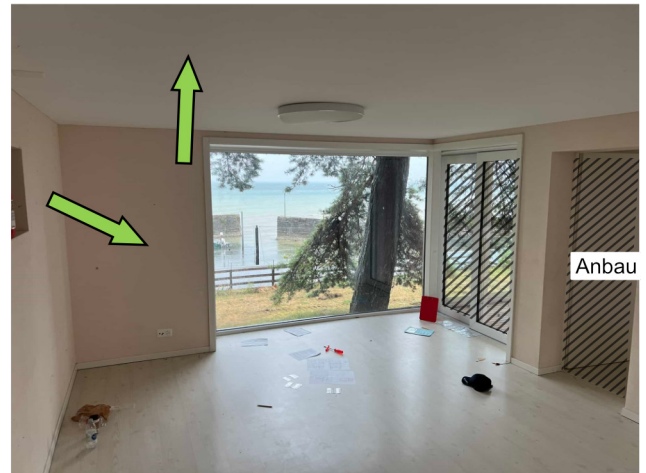
EG, Wohnen VP11-1: Wandverputz Wohnen, kein Asbest Deckenverputz auf Gipsplatten baugleich VP12: kein Asbest Laminat, Fenster: kein Asbestverdacht
