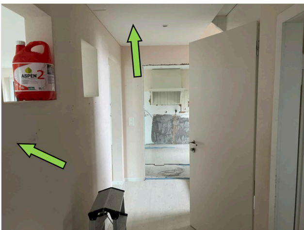
EG, Gang VP6-1: Wandverputz Gang, kein Asbest Deckenverputz Gang baugleich VP7: kein Asbest Laminat: kein Asbestverdacht
