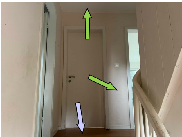
OG, Gang VP6-2: Wandverputz Gang, kein Asbest VP7: Deckenverputz Gang, kein Asbest Holzboden, darunter Zwischenbodenschlacke baugleich S1: PAK- und SM-haltig
